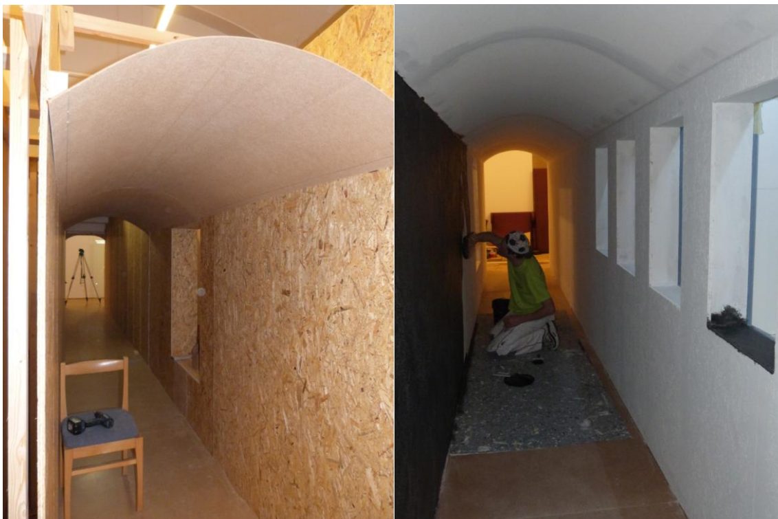
Stavba průchozího modelu železničního tunelu Adria.
